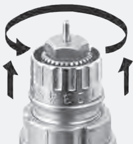
Рис. 19. Предварительная настройка клапана Danfoss
